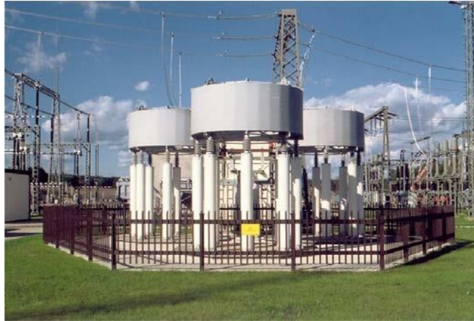
Bild 4: 20 kV 45 MVar 3-fas tertiär shunt reaktor
