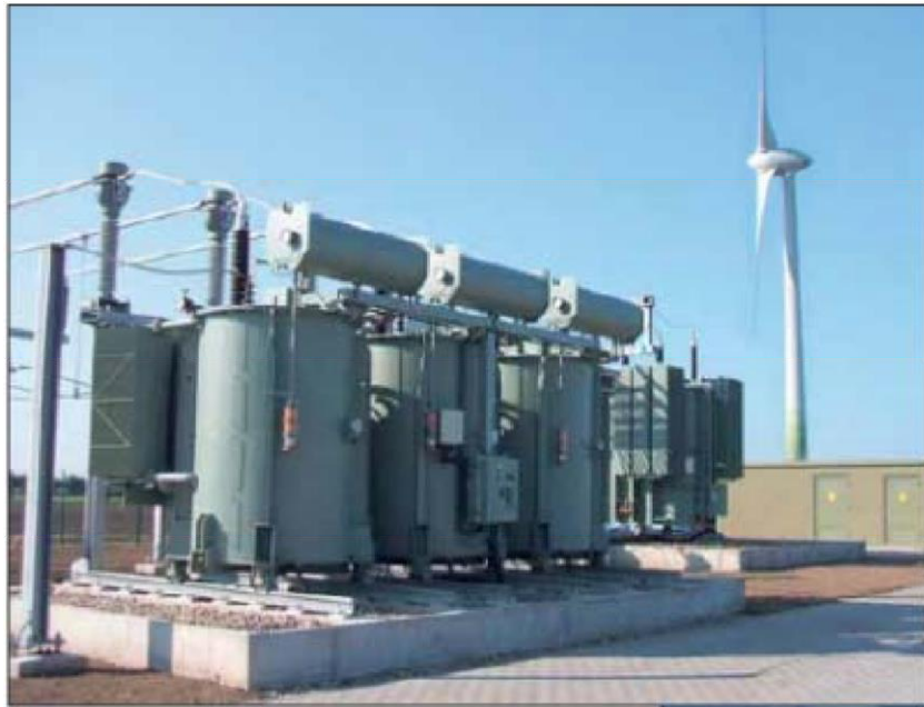
Bild 7: Exempel på en större, under drift, steglöst reglerbar shuntreaktor från Trench Austria
